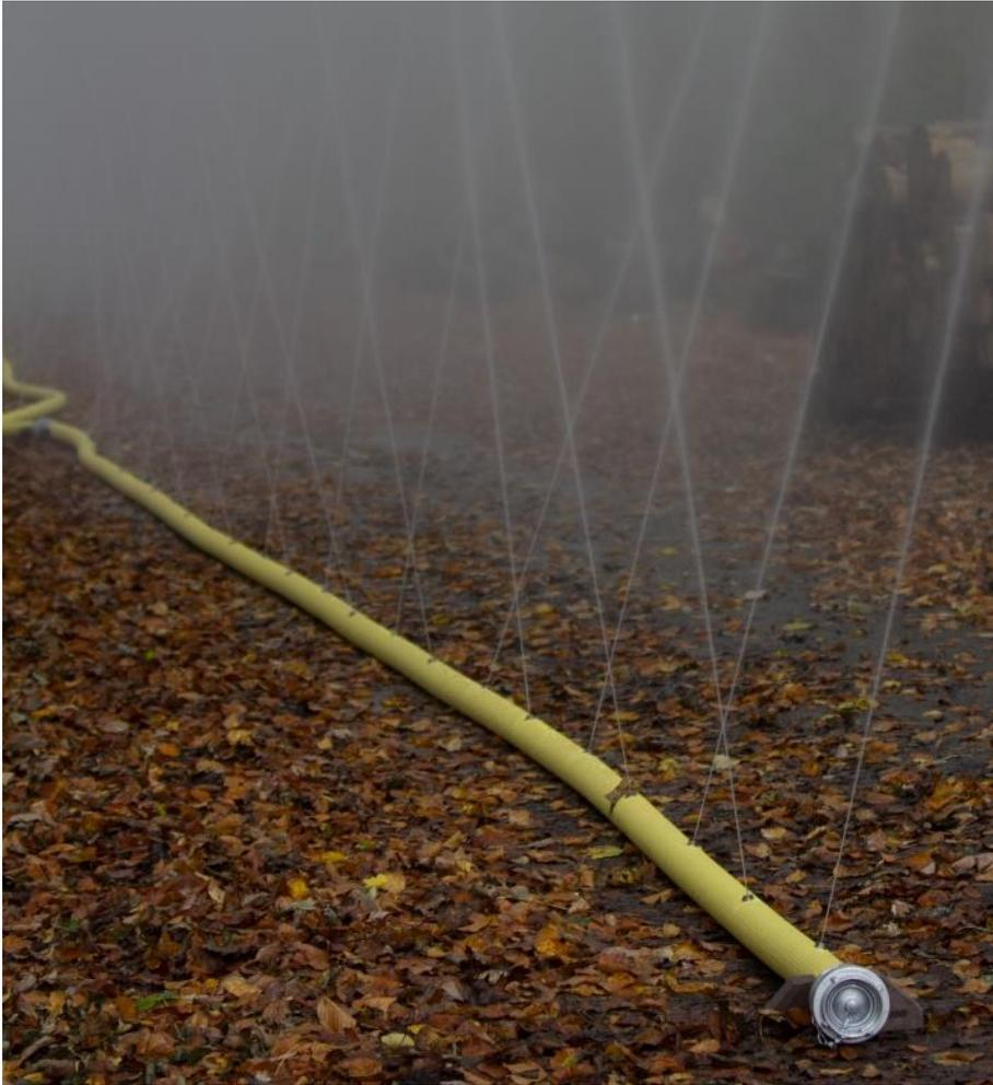
Abb. 7.8: Düsenschlauch im Einsatz
